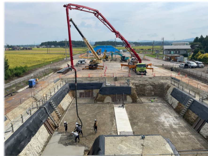
均しコンクリート打設状況
