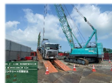
コンクリート打設
