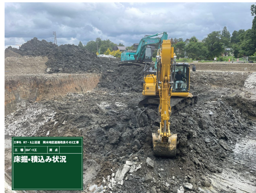
床掘作業状況
