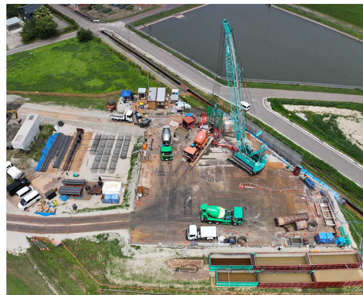
【現場施工状況空撮】
