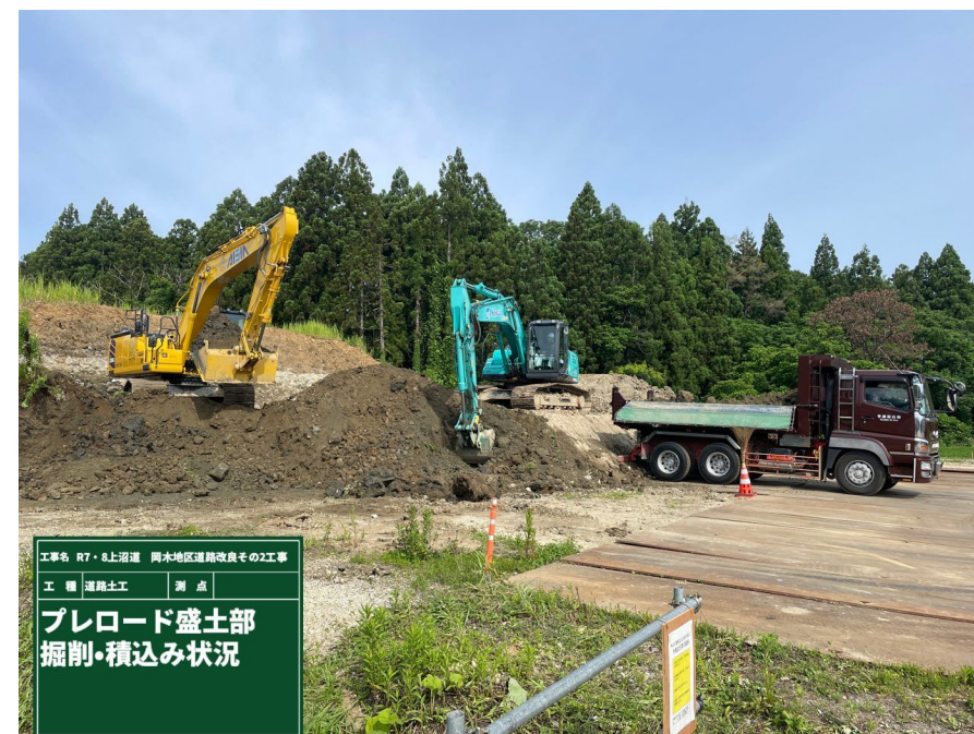
掘削積込み作業状況
