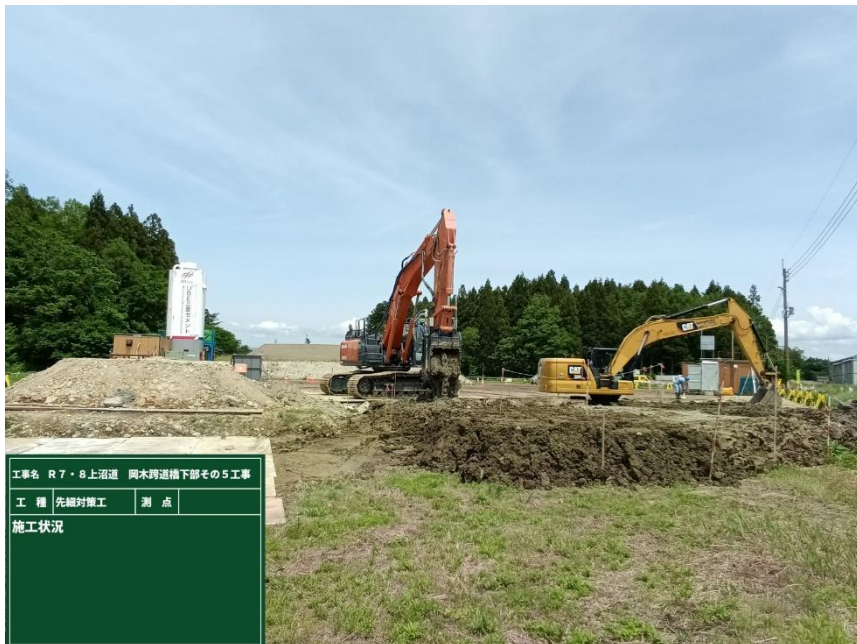
地盤改良(中層混合処理)施工状況 ※杭頭付近の地盤改良を行い、場所打ち杭の先細りを防止します。
