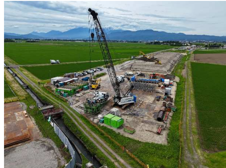
《 場所打杭工 施工全景 》
