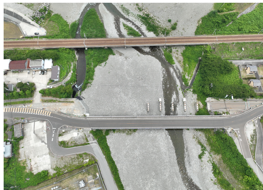
境橋 旧橋撤去 完了
