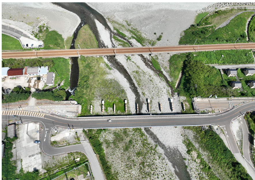
境橋 旧橋撤去 着手前
