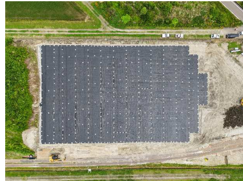
《ジオテキスタイル 施工完了》
