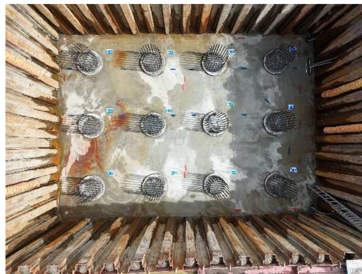
《 杭頭処理完了 》
