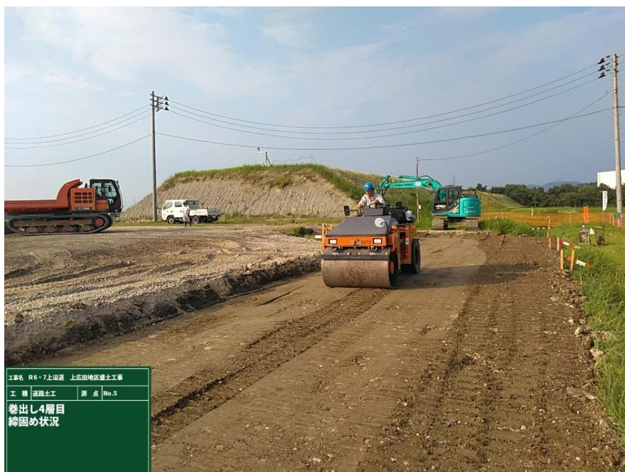
市道迂回路 路床盛土施工状況
