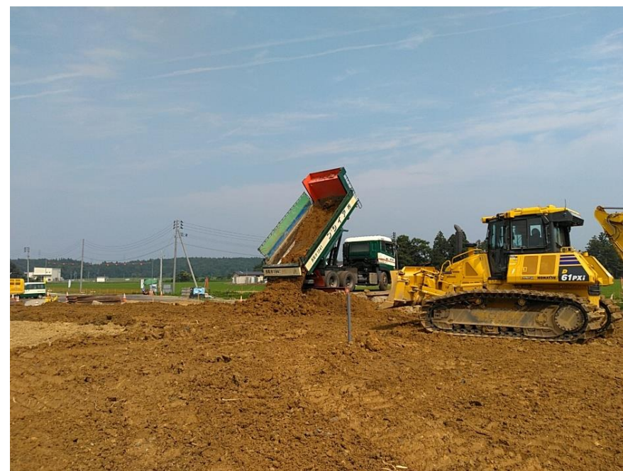
本線 路体盛土施工状況
