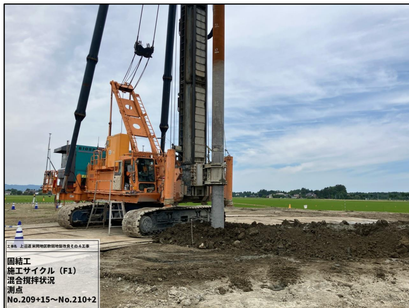
《6月度施工状況 混合攪拌状況》
