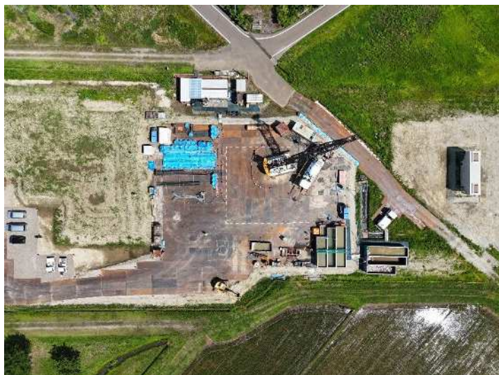
《 施工範囲全景 》
