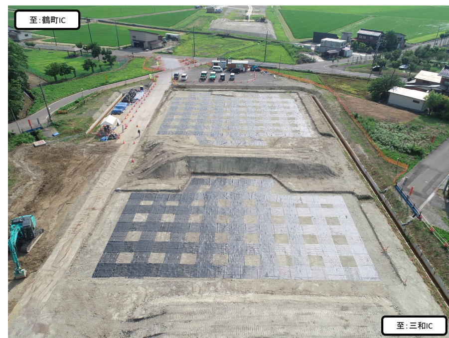
作業状況〔ジオテキスタイル工〕
