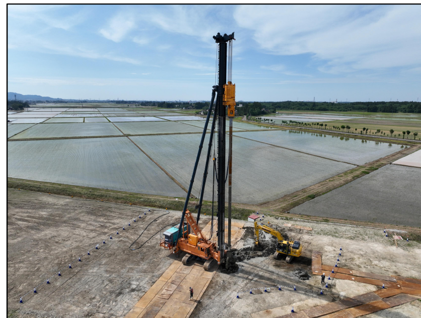
《5月度施工状況 混合攪拌状況》
