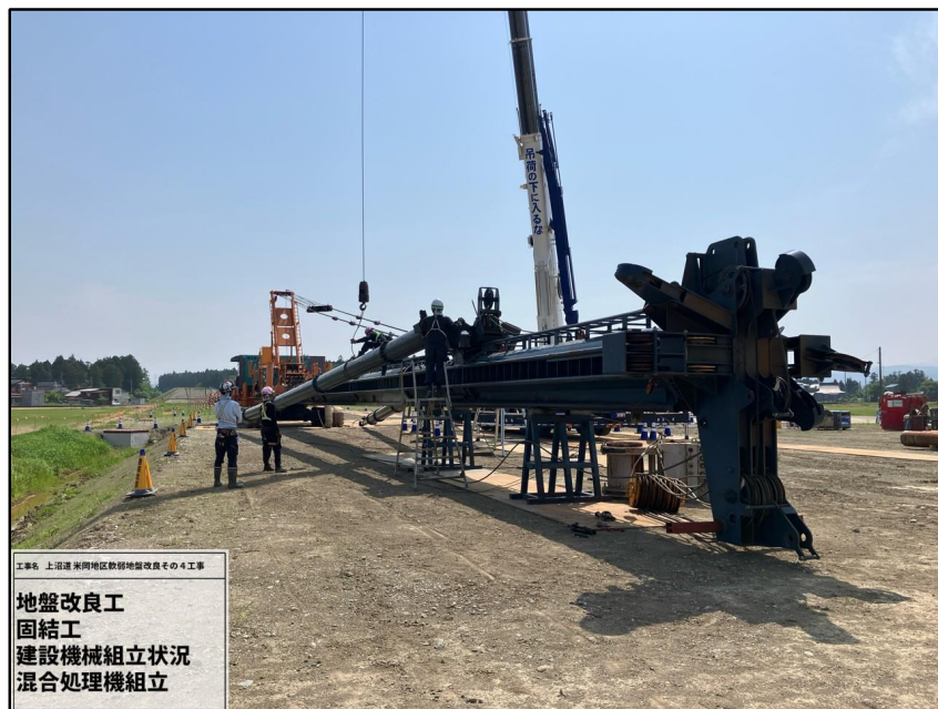
《5月度施工状況 混合処理機組立状況》
