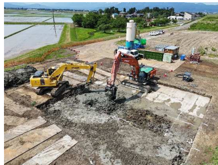
《 地盤改良施工状況 》
