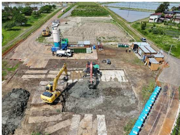
《 施工範囲全景 》
