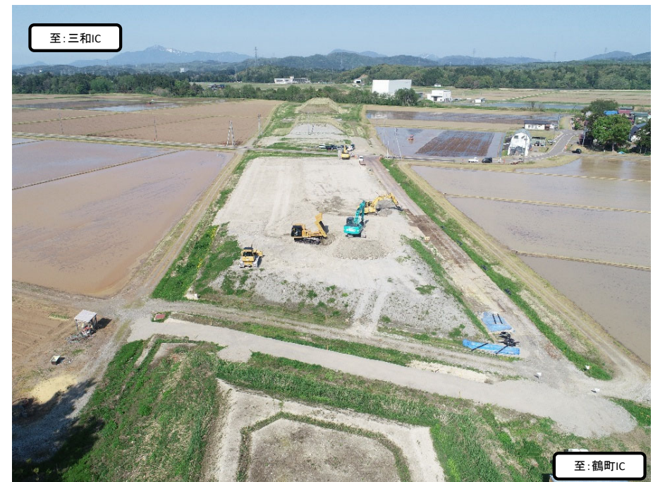
作業状況〔上広田地区(起点側)〕
