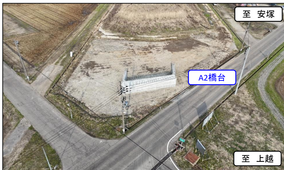
完成現場空撮
