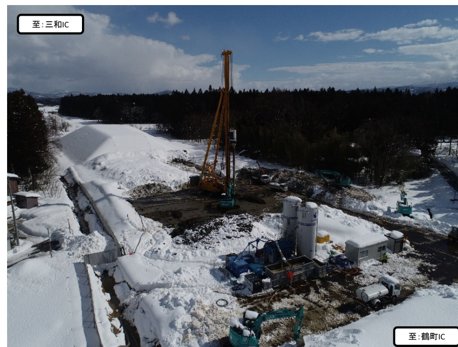
作業状況〔米岡地区(起点側)〕
