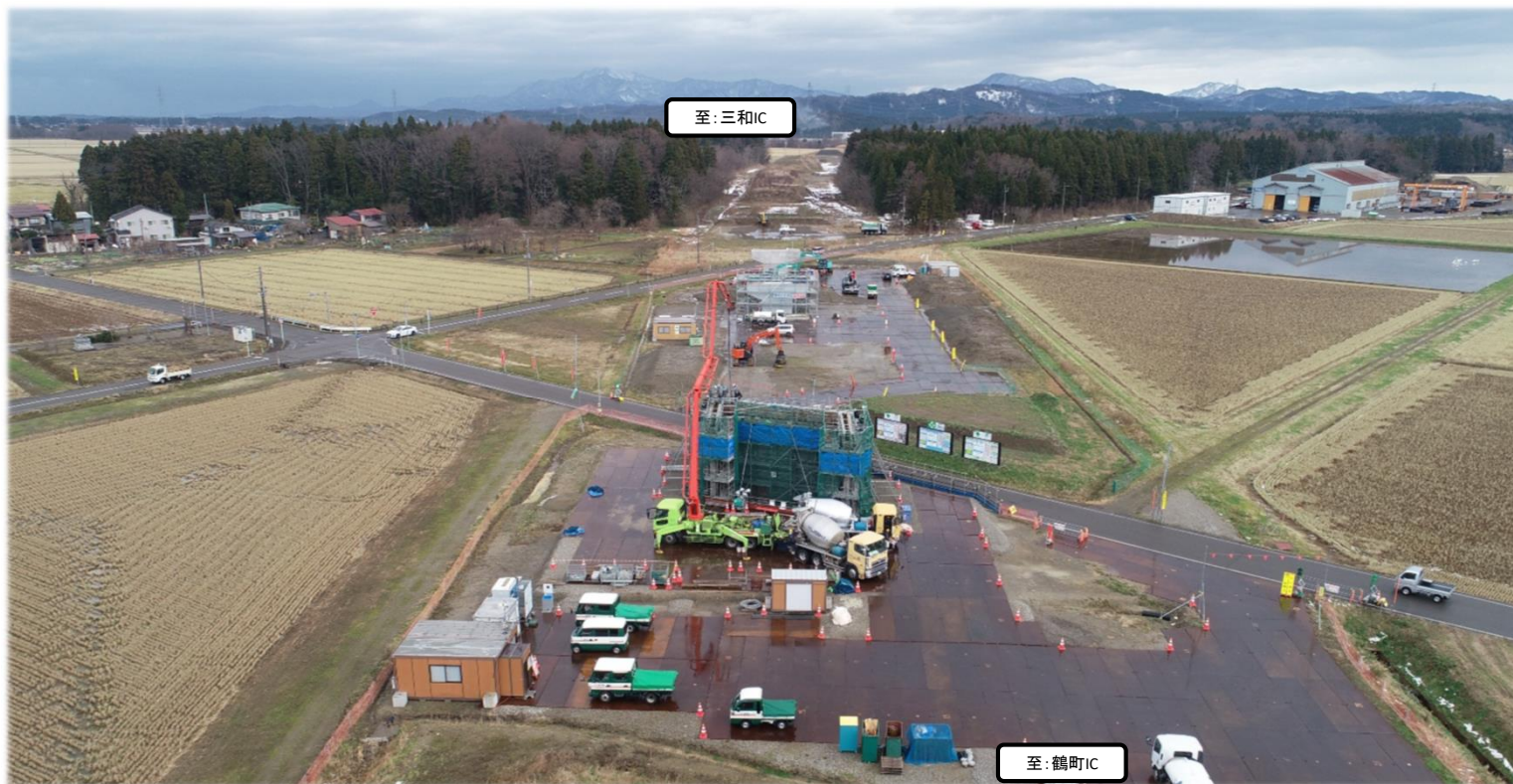
コンクリート設状況
