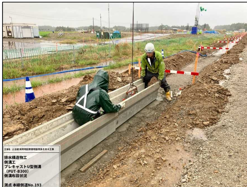
《10月度施工状況 側溝工》
