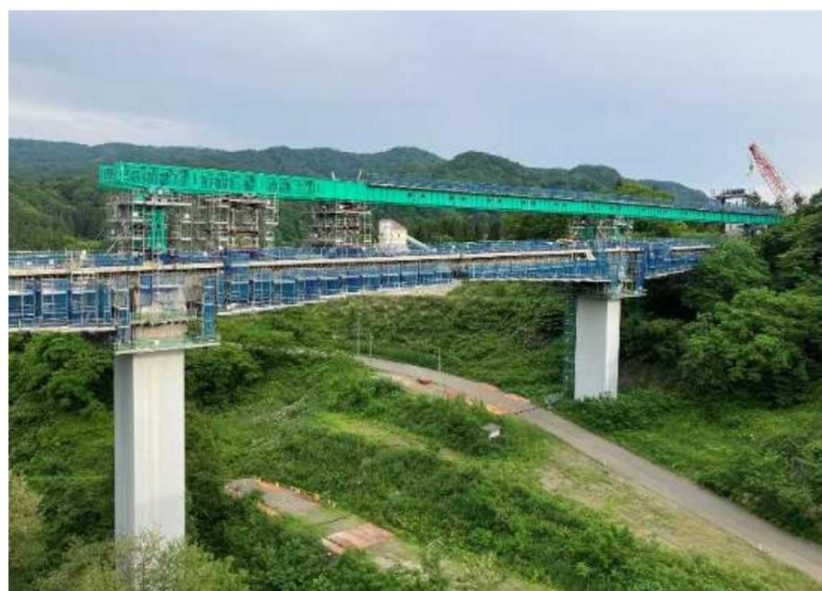
架設桁・吊り装置組立状況
