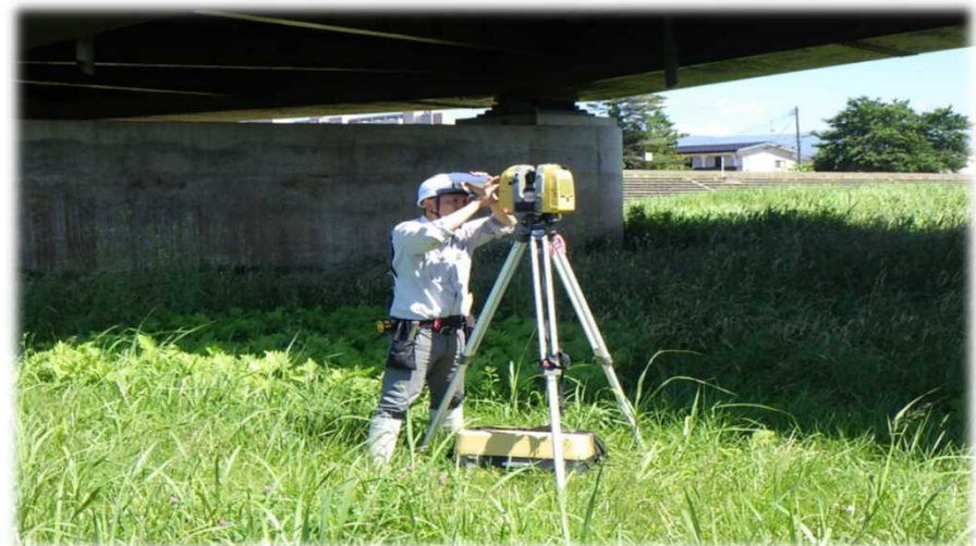
地上型レーザースキャナーによる橋下3次元起工測量
