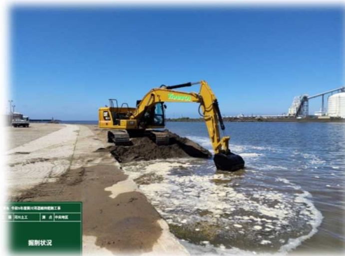
河道掘削状況 (1.0m3級ICTバックホウ使用)
