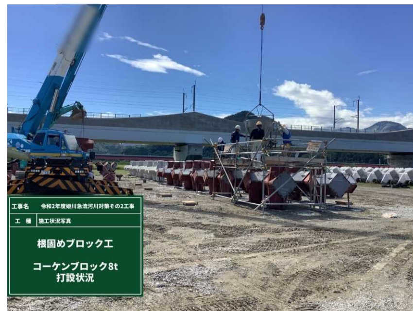
コンクリート打設作業
