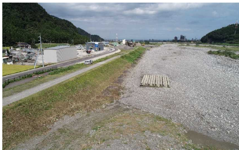
【西中地区 着手前】
