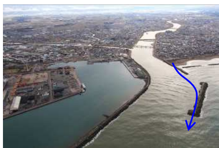
関川河口部の状況
