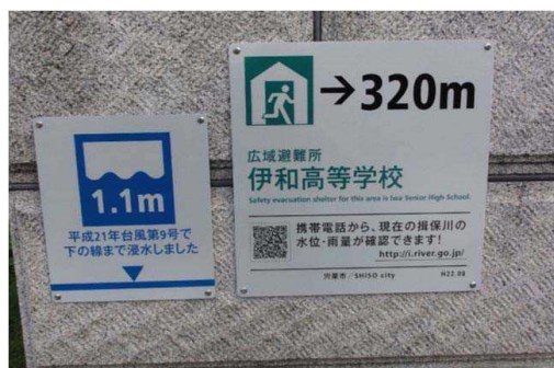
壁に設置 実績浸水深、水位の高さ、避難所、避難所の方向、避難所までの距離を明示している〔出典／姫路河川国道事務所HP〕
