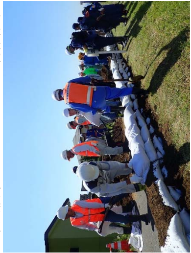
●市民積み土のう工－土のう制作作業
