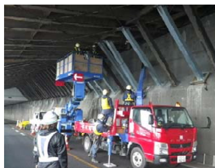
(洞門修繕：鋼製部材の更新等)
