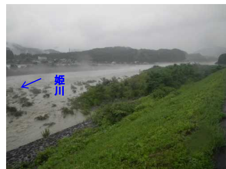
平成29年7月洪水で 水衝部となった西中地区
