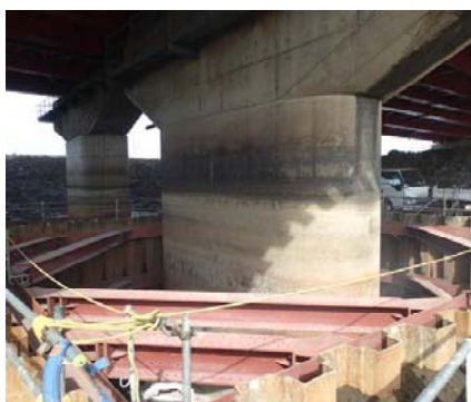
(耐震補強：橋脚巻立)
