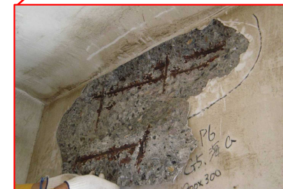
写真① 主桁の損傷状況 ※現在は補修済み
