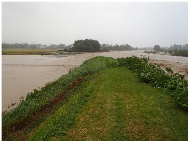
堤防決壊（13日 5:30頃）直後の状況
