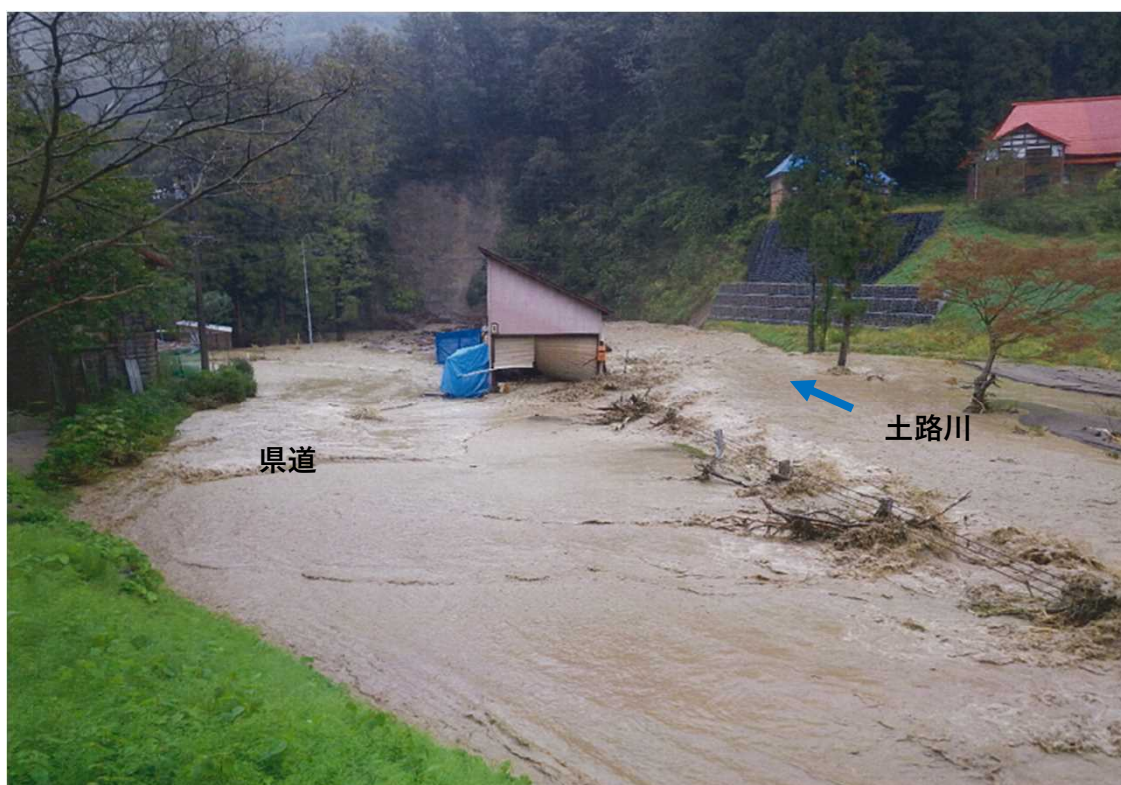
出水時の土路川と（主）飯山斑尾新井線
