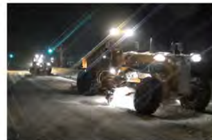
除雪車による除雪状況(国道8号)
