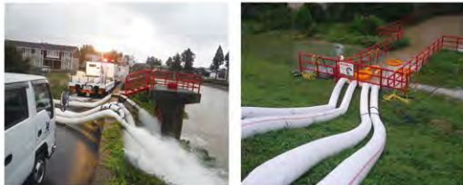
排水ポンプ車による内水排除 (令和元年東日本台風)
