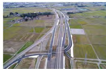
部分開通(H31.3)した上越三和道路
