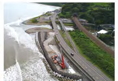
架替工事が進む有間川橋
