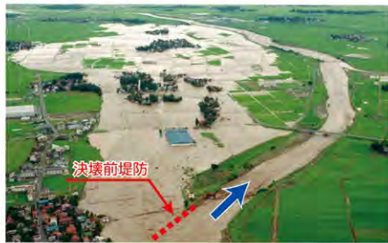
平成7年7月 関川出水 妙高市円岡地先堤防決壊状況
