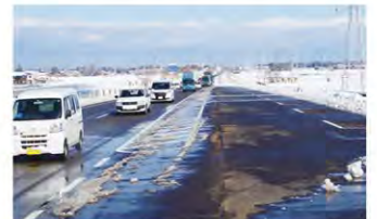
チェーン着脱溝の設置(国道18号 上箱井)
