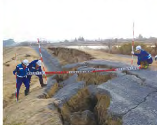
東日本大震災(H23.3)での被災調査状況
