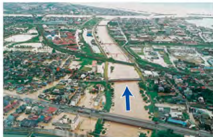
平成7年7月 保倉川出水・浸水状況
