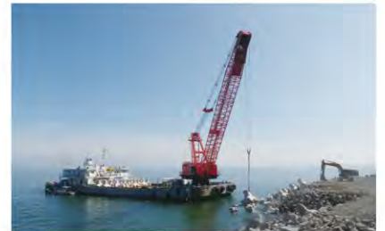
防災対策(国道8号 糸魚川市向山地先)
