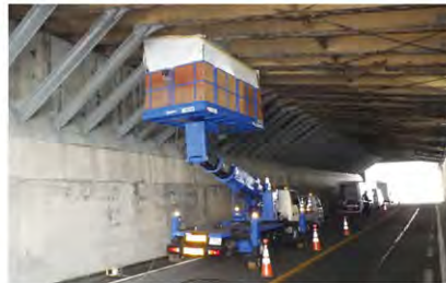
洞門補修(国道8号 糸魚川市赤崎地先)
