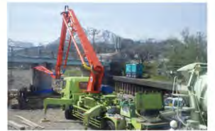
橋脚の補強(国道8号 田海川橋)
