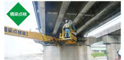
橋梁点検(国道8号 青海川橋)
