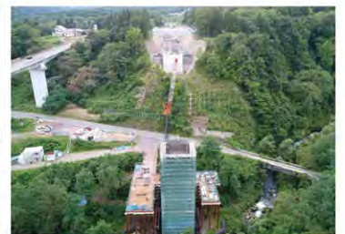
新橋の架替工事が進む妙高大橋
