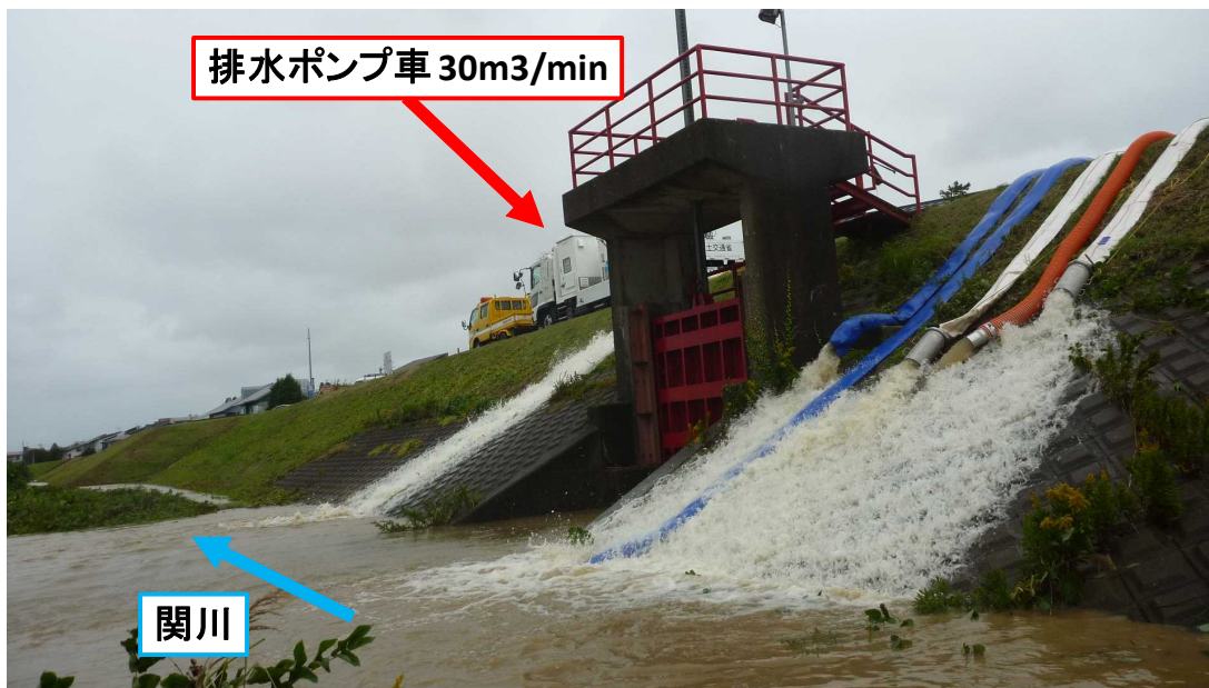
鴨島地先 古川排水樋管門 排水状況 平成29年10月23日 12:00
