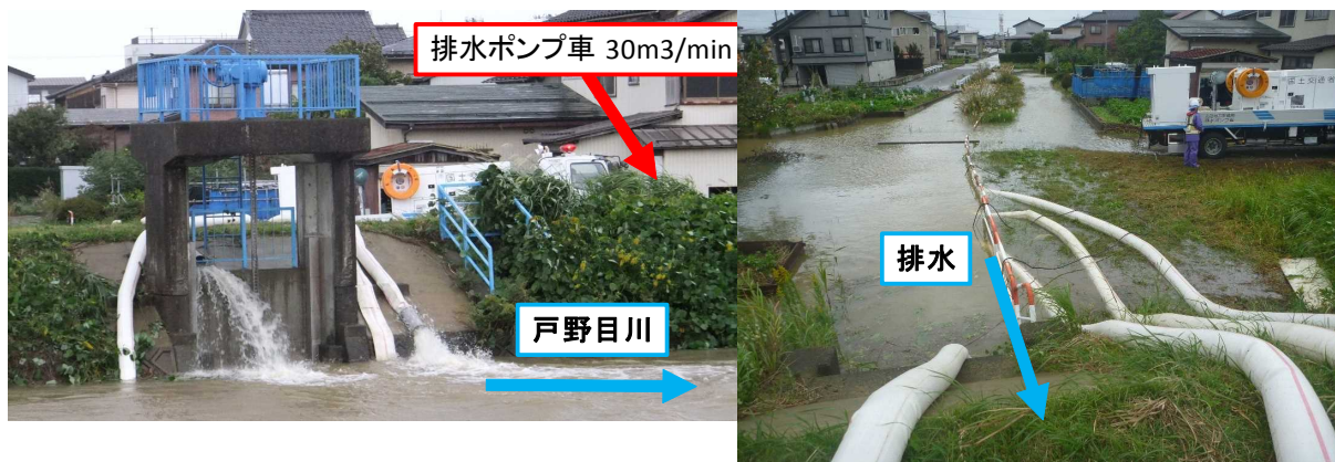
上越市春日新田地先 春日新田二号樋門 排水状況 平成29年10月23日 11:50
