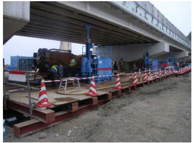
施工状況(弁天大橋 地盤改良工)
