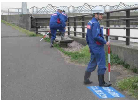
ベンチの老朽化状況点検写真(関川)
