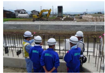
工事現場見学
