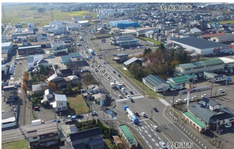
上越市三ツ屋付近から糸魚川市方面を望む（写真左側が山側） いといがわ
