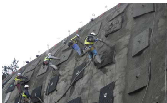
(防災対策：法面对策)
