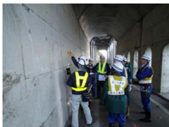
(トンネル点検)
