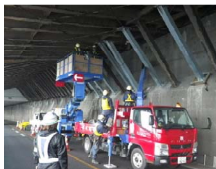
(洞門修繕：鋼製部材の更新等)
