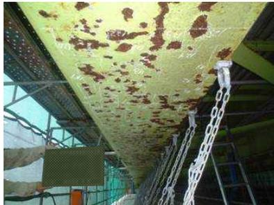
鋼材の塗装劣化・腐食状況
