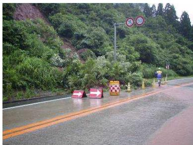
法面崩壊、土砂流出状況
