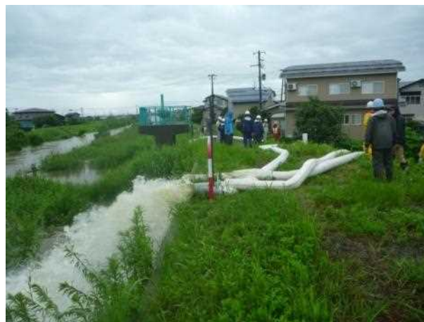
■上越市下源入地内での内水排除状況（平成 29 年 7 月 1 日）
