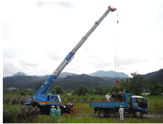
■備蓄ブロック積込状況
