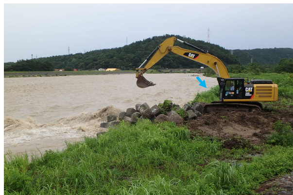
平成 29 年 7 月 4 日 ブロック投入
