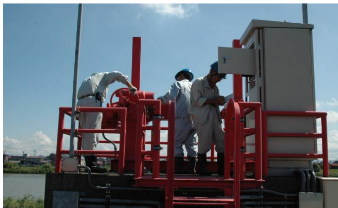
河川管理施設の点検状況
