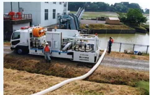
排水ポンプ車による排水訓練
