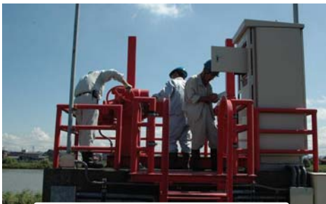
河川管理施設の点検状況
