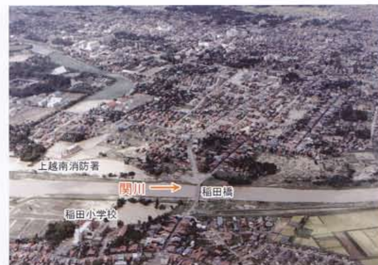
関川稲田橋上空から 上越南消防署や稲田小学校をはじめ、兩岸の広い地域が浸水しました。
