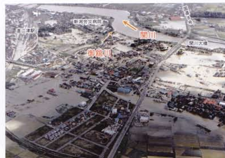
上越市石橋付近上空から 御館川が氾濫し、栄町・石橋・新高町各地にも大きな被害が出ました。
