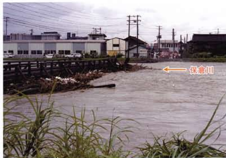
保倉川佐内橋 右岸側（写真向こう側の岸）の部分が流失しました。 保倉川下流は、降った雨水が川に流れ込むことができなくなる内水氾濫による被害が多く起こっています。
