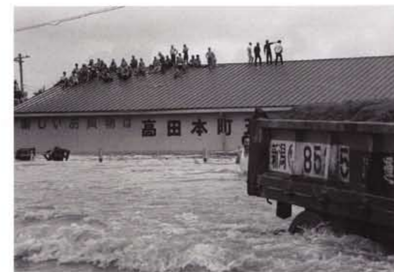
上越市藤巻付近 旧国道18号（現在の上越大通り） 関川と並行していた旧国道18号は水害の際に度々浸水していました。ダンプカーのタイヤが埋まるほどの水深があり、屋根の上に避難する人の姿も見えます。
