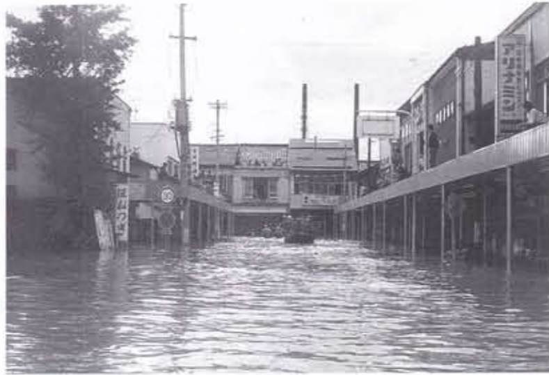
直江津南小学校の前付近から直江津駅前通り方向を見た写真 道路標識が半分ほど水に浸かり、雁木の上に避難している人の姿が見えます。 写真出典：アルバム直江津（北越出版 刊）
