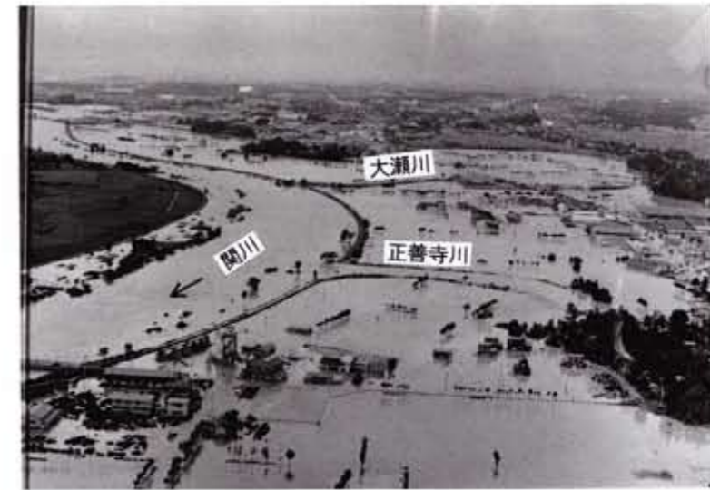
上越市藤巻付近上空から 関川だけでなく支川の正善寺川や大瀬川も氾濫し、市街地にまで被害が広がりました。
