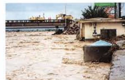
破堤の状況（糸魚川市上刈）
