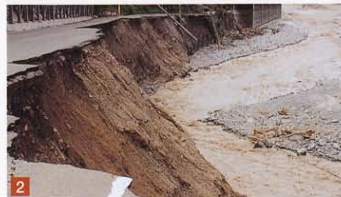
崩壊した国道148号（糸魚川市平岩）
