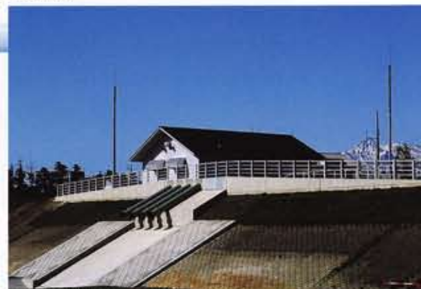
水戸の川排水機場(上越市北城町)
