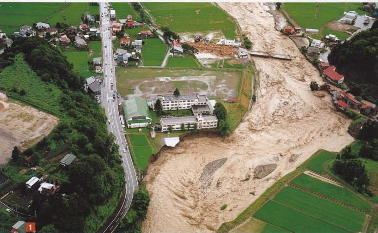
新井南中学校 プール全壊（妙高市＜旧新井市＞除戸）
