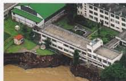
新井南中学校（妙高市＜旧新井市＞除戸）
