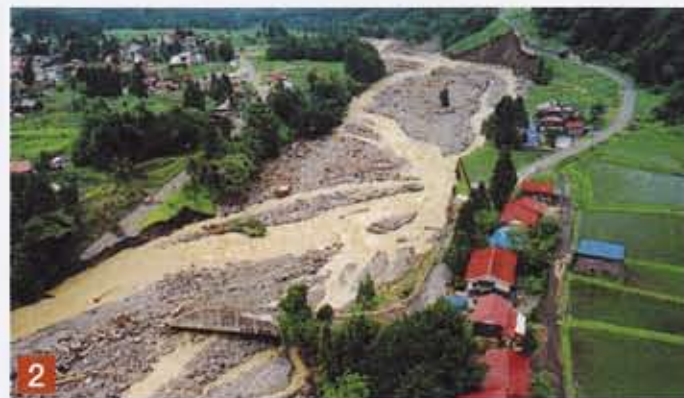
土砂の異常堆積により道路・橋梁が流失（信濃町高沢）
