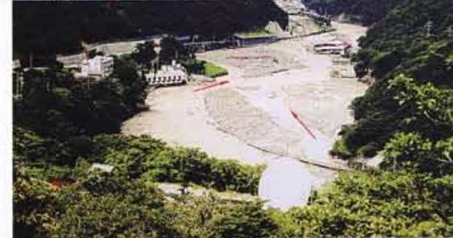
葛葉峠より望む異常埋塞土砂の状況（上：発生前、下：発生後）
