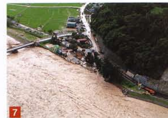
護岸が倒壊し、堤防が決壊（糸魚川市上刈）
