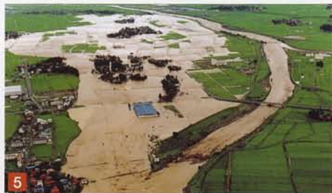
堤防が決壊 家屋・田畑に浸水（妙高市＜旧新井市＞月岡）
