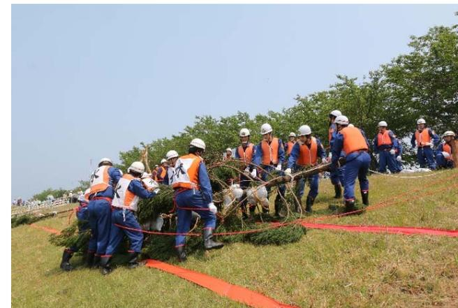
●月の輪工－漏水を再現した訓練
