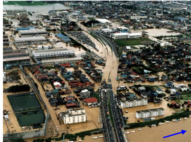
保倉川大橋左岸側（浸水状況）
