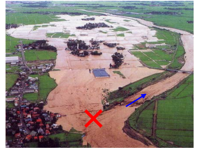
妙高市月岡地先 破堤
