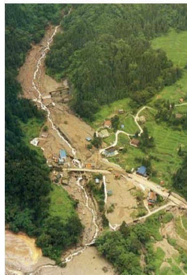
湯原 土石流発生状況
