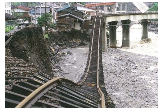
糸魚川市平岩 JR大系線被害状況
