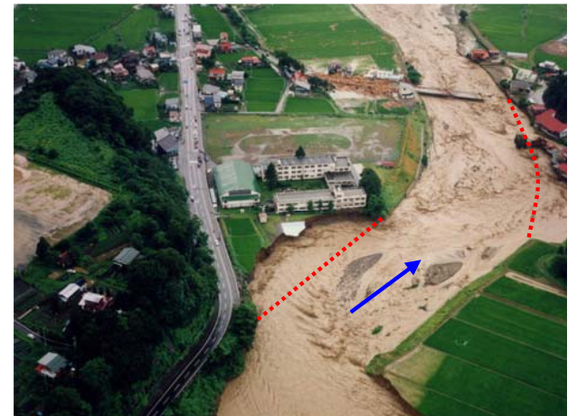
新井南中学校（当時） 河岸侵食
