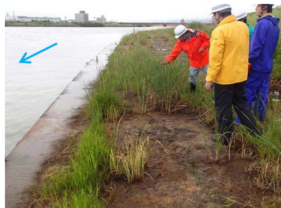
【出水期前（関川左岸 東雲町地区）】
