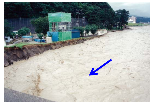
糸魚川市上刈 破堤状況
