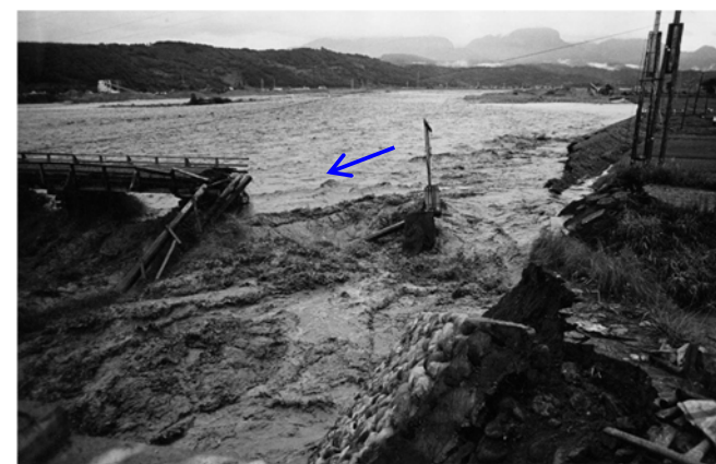
昭和44年8月洪水(水害) 大野地区 (押し流された今井橋と堤防)
