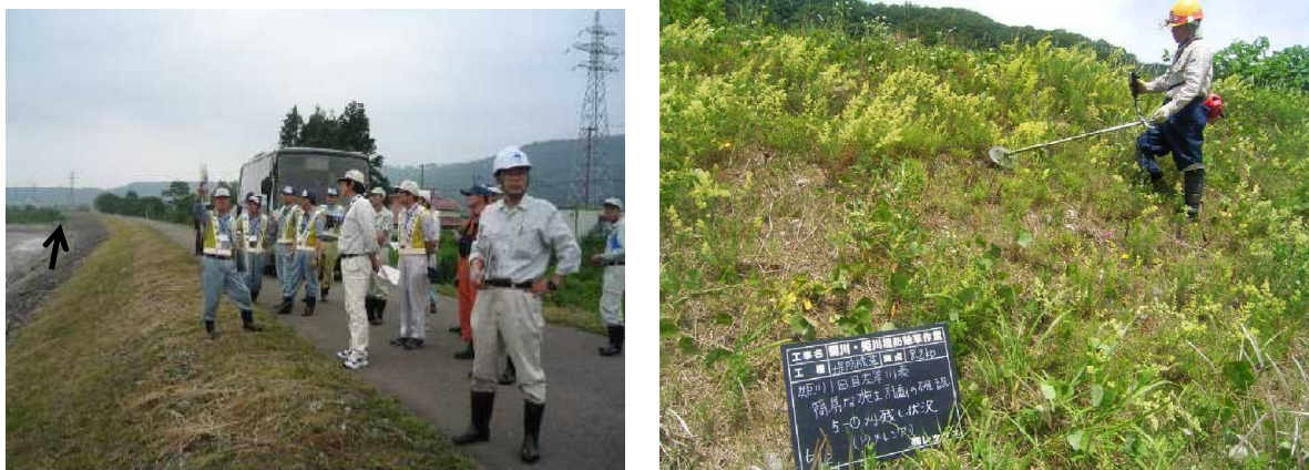
図 5-11 堤防の点検および除草状況
