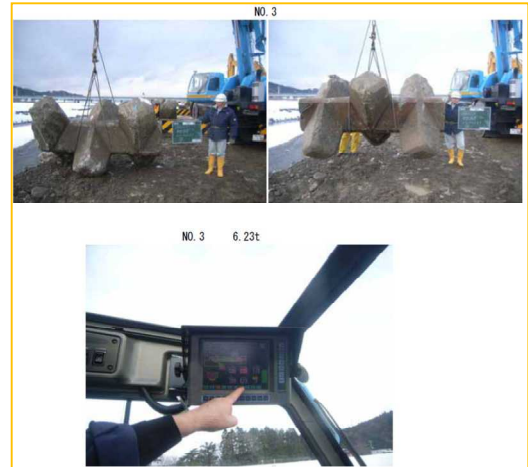
図 3-21 河川工事実施時の計測状況 （クレーンによる重量計測）
