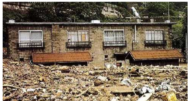
写真 2-35 土砂流出により 1 階部分が埋まった住宅（小谷村光明下）
