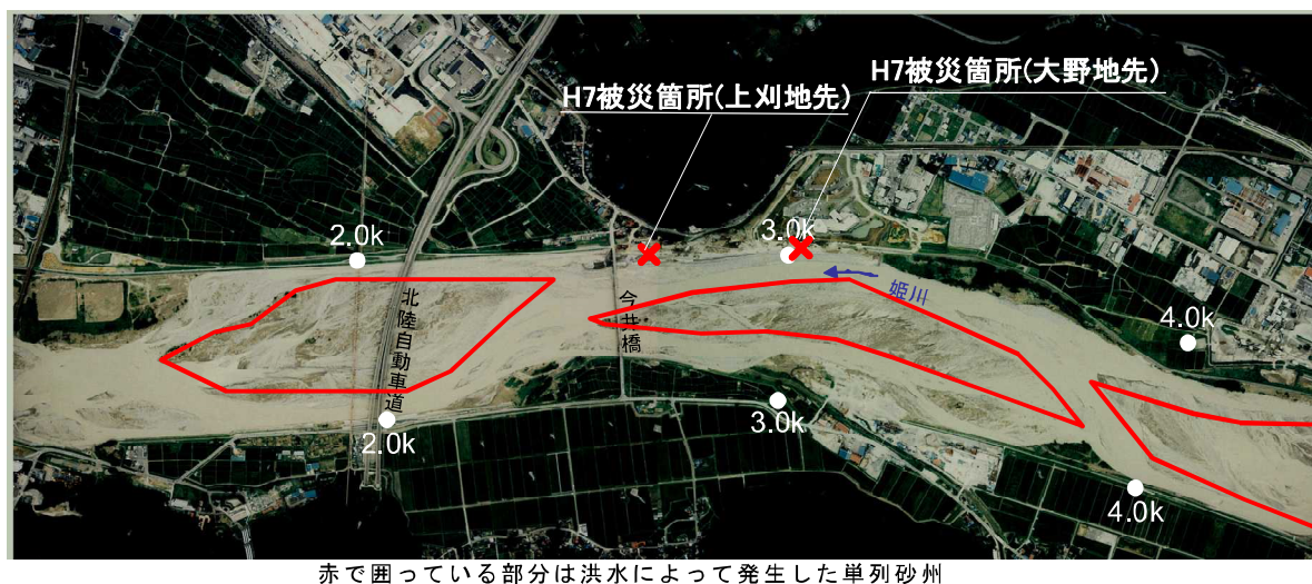
図 3-17 空中写真による洪水直後の河道の状況（H7.7.11 洪水）
