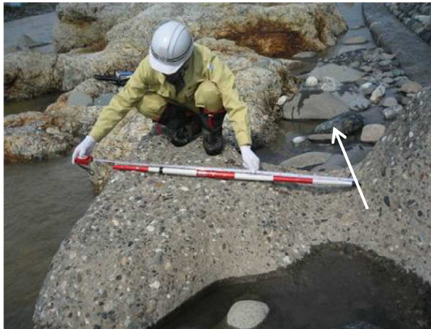
図 3-20 現地での計測状況（右岸 6.0k 付近）
