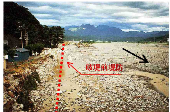
写真 2-31 洪水後の河岸洗掘による堤防の決壊状況（糸魚川市上刈地先）
