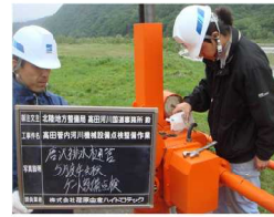
減速機の潤滑油給油
