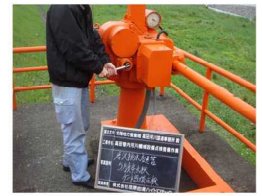
巻き上げ機の動作確認
