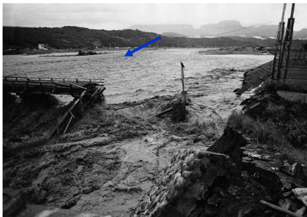
写真 2-26 昭和 44 年 8 月洪水 (押し流された今井橋と堤防)
