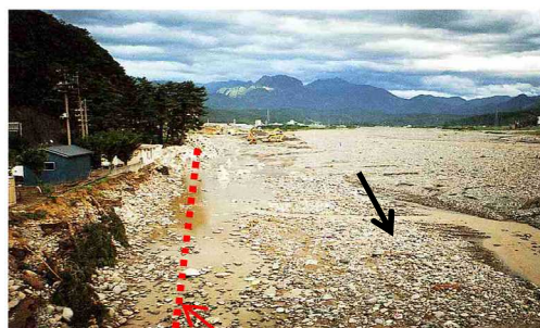
破堤前堤防位置
