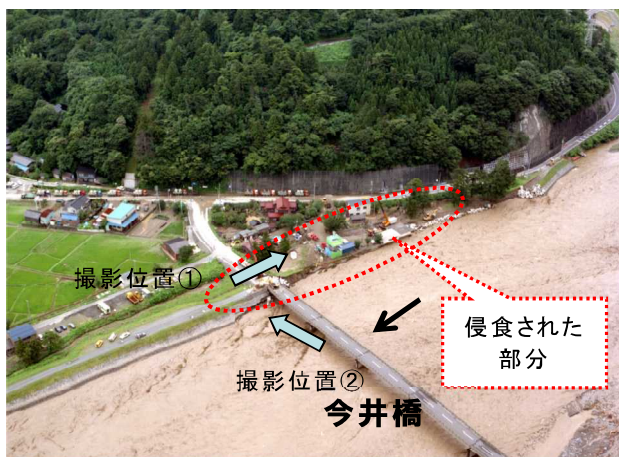
図 3-1 河岸の洗掘による破堤（堤防の決壊） （糸魚川市上刈地先：河口から）
