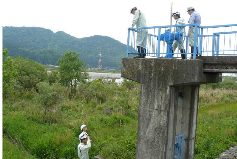
図 3-22 樋門・樋管等の定期点検(横戸第一排水樋管)
