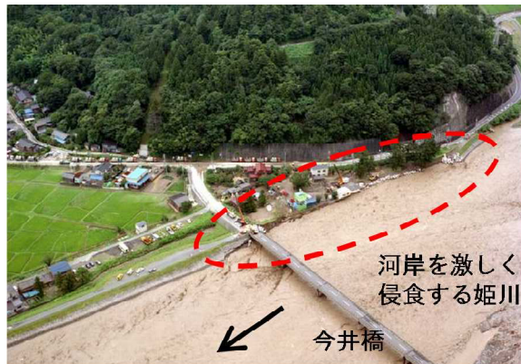
写真 2-30 洪水時河岸洗掘による堤防の決壊状況（糸魚川市上刈地先）
