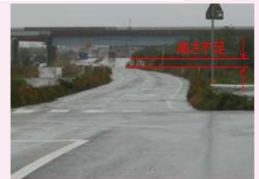
▲堤防断面の不足状況
