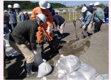
▲水防工法研修
