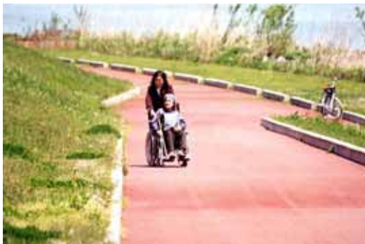
上越市東雲地区のバリアフリー川づくり (緩傾斜坂路の利用状況)
