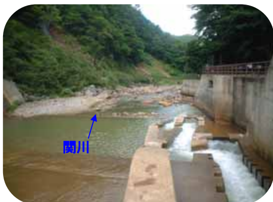
維持放流実施状況 (高沢発電所第一堰堤)
