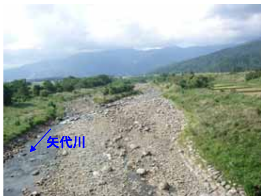
矢代川減水区間の状況 (平成17年10月撮影)
