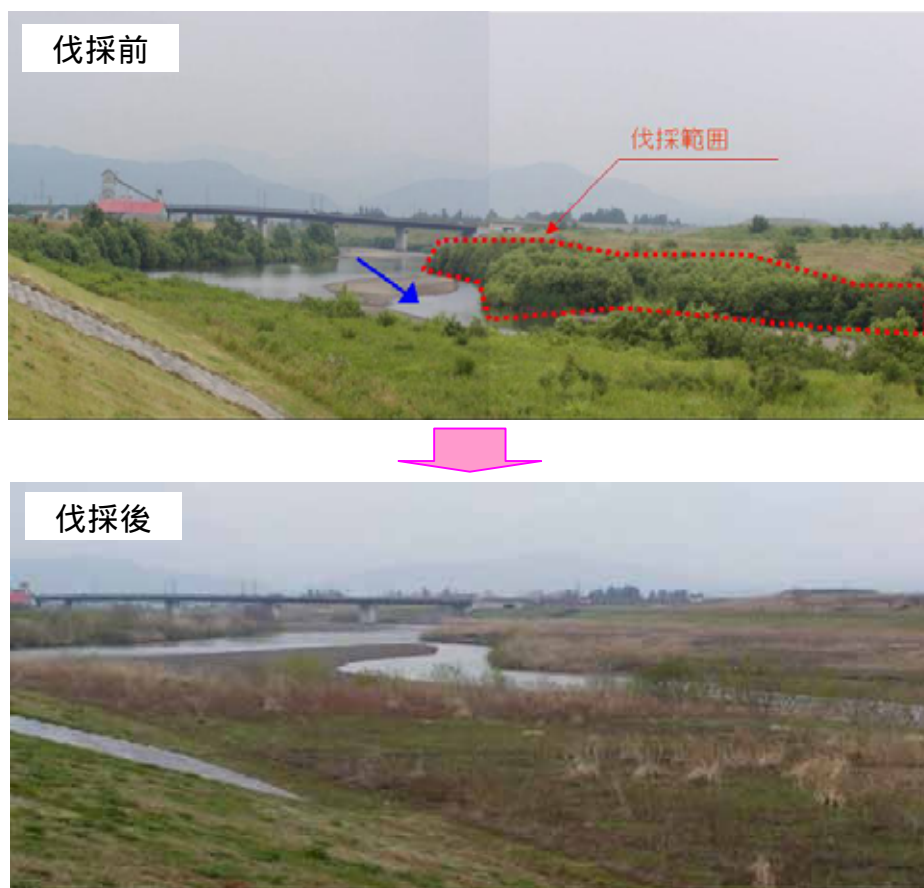
河道内樹木群の伐採状況 (平成18年度 東城町地先)
