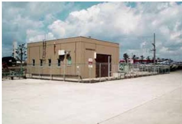
春日新田川排水機場
