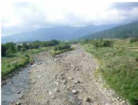
矢代川減水区間の状況
