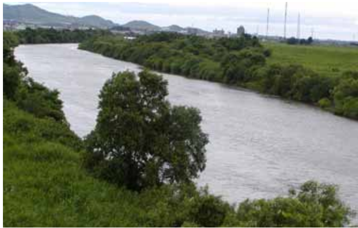
河道内樹木群の繁茂状況(関川右岸 6.0～6.8k 付近)
